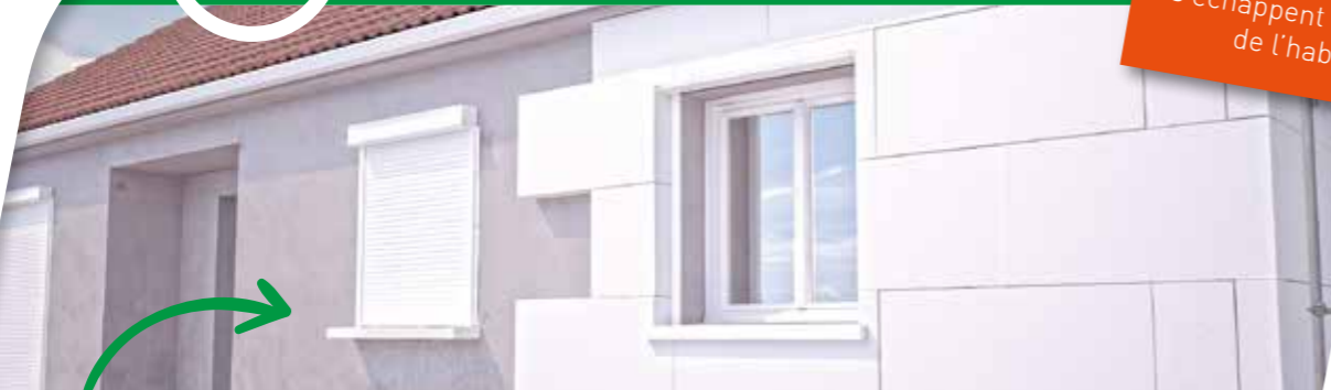
Création d'un manteau isolant sur la façade extérieure : facture énergétique réduite !
