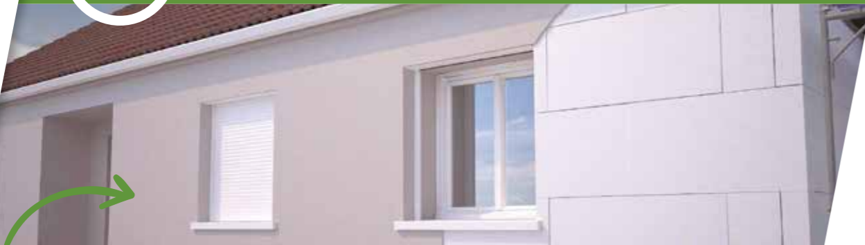
Façade imperméabilisée, fermetures rénovées : performance d'isolation globale éligible aux exigences RT 2012 et BBC !
