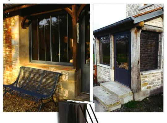
Un pareclosage simple et traditionnel permet le maintient de vitrage de 28 à 44 mm d'épaisseur.
